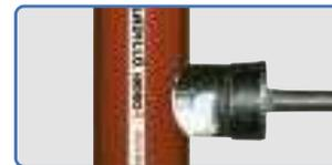
1- Realice un orificio de 10 mm. luego perfora la tubería utilizando la fresa H3 provista.
